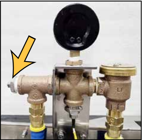
Fig. 30 - Rinse manifold
